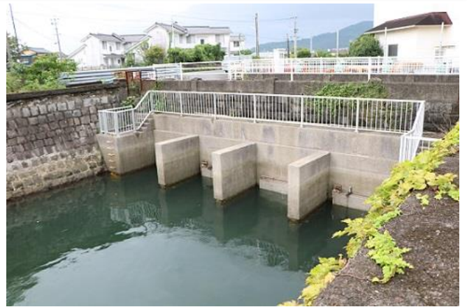
[写真] 丸島排水溝
